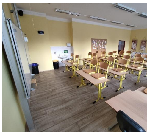
Opravená podlaha v učebně
