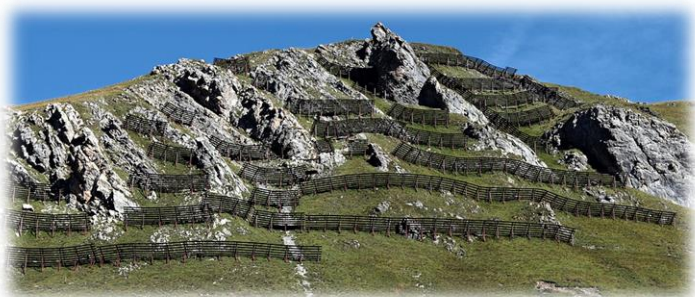
Ploty, které zabraňují hromadění sněhu na jednom místě.
